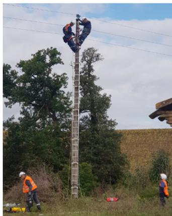
Remplacement de l'armement HTA par deux monteurs. Ascension à l'échelle.
